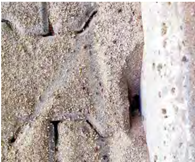
Abb. 4: Sandauswürfe an untergrabenen Pflastersteinen, Hauswänden oder Randsteinen, manchmal über mehrere Dutzend Meter, sind typisch für Tapinoma magnum Worms. (Foto: Manfred Alban Pfeifer, 5.8.2025)
