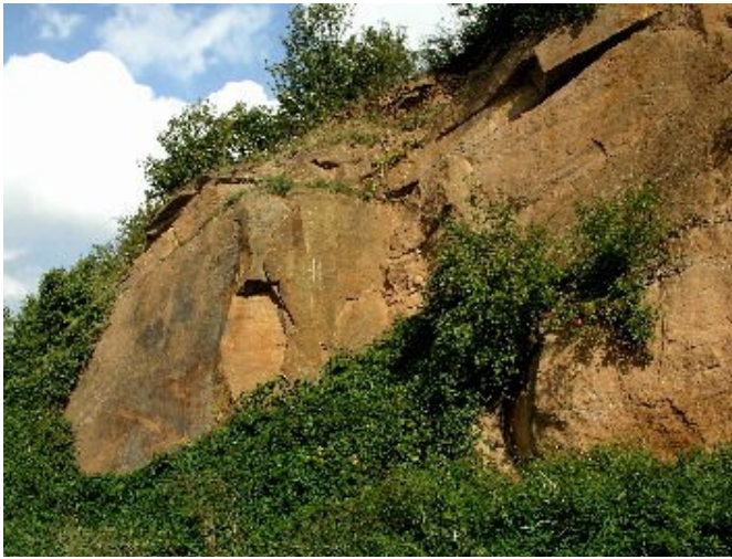
5. Straßenanschnitt (Htndenburgblick) südlich Duchroth (32:0407965 E, 5514756 N). konglomeratische Sandsteine der Oberkirchen-Formation, unteres Rotliegend
