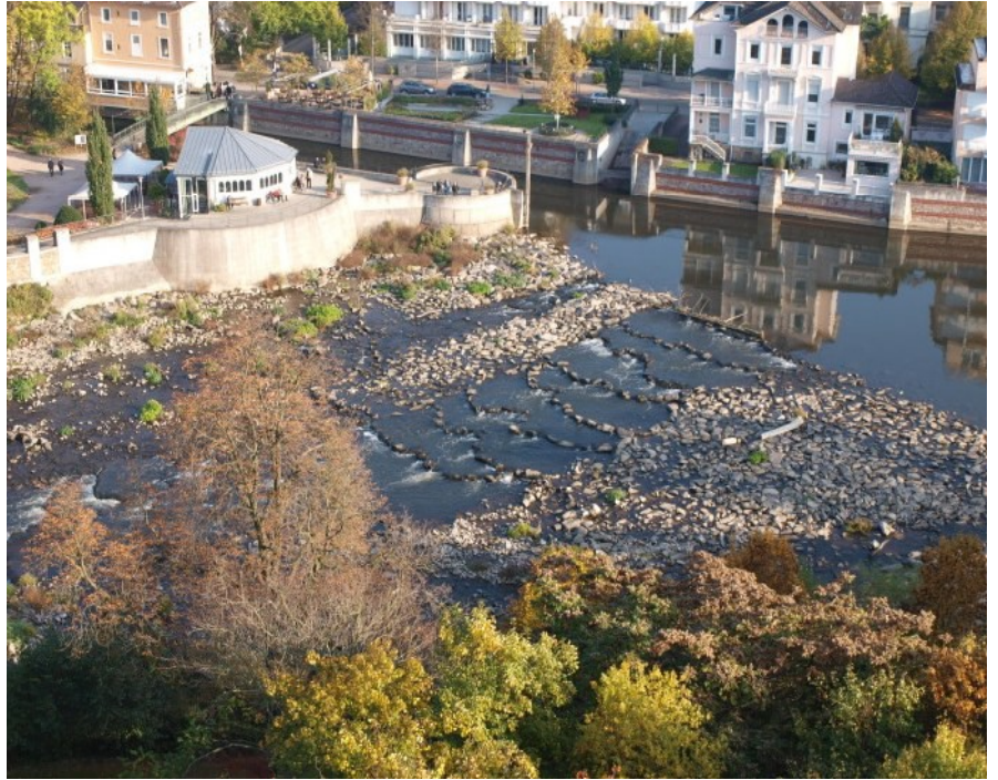
Abb.: 13 Fischtrappe in der Nahe
