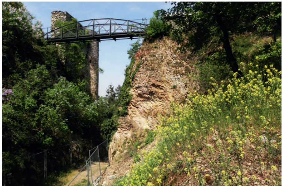
Abb. 2: Brückenkopf auf der Nordostseite der Burg Altenbaumburg mit Massenbestand von Schöterich (Ende April 2020).
